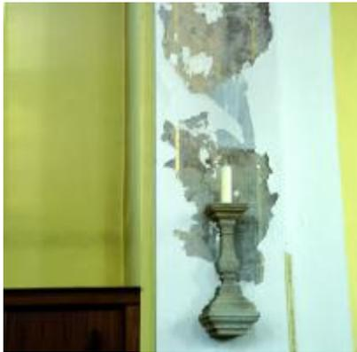
Fast vierzig Jahre nach der letzten, umfassenden Renovierung der Liebfrauenkirche sind es technische, bauphysikalische und durch Verschleiß bedingte Schäden an der Fußbodenheizung, am Putz, an den Fenstern, an der Orgel, an den Bänken sowie starke Verschmutzungen und Schäden an den Decken und Wänden, welche die Notwendigkeit einer grundlegenden Sanierung und Erneuerung offensichtlich machen.
