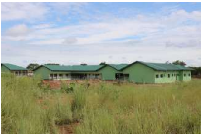
Blick zum Klinikneubau
