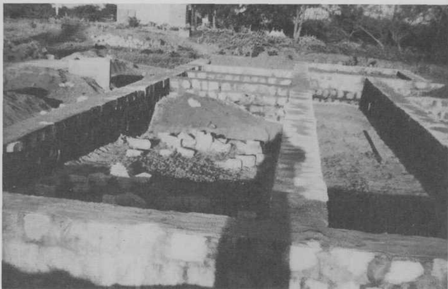
Die ersten Fundamente des Sozial-Centrus Thondi in Südindien. Das Samenkorn der Kolpingfamilie Hl. Kreuz geht auf!
